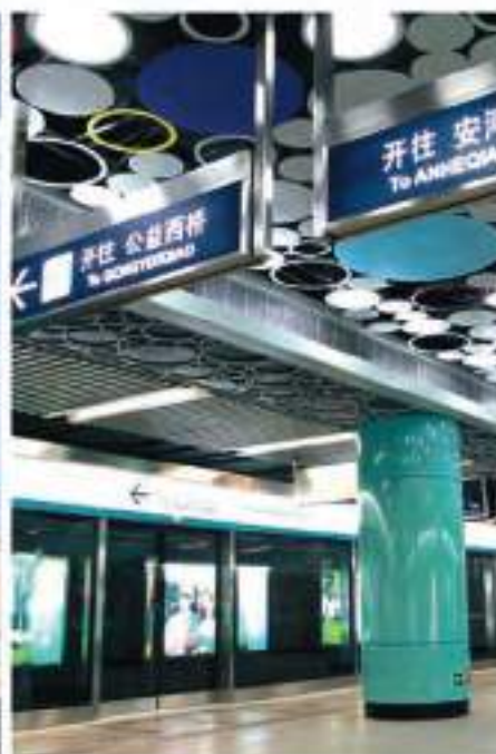
Kraj: Chiny Nazwa projektu: Linia metra Fangshan w Pekinie Seria produktu: Chłodzony wodą odśrodkowy agregat wody lodowej z łożyskami magnetycznymi
