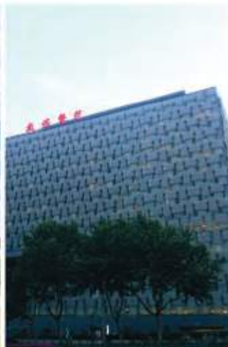
Kraj: Chiny Nazwa projektu: Szpital Nanjing Drum Tower Seria produktu: Chłodzony wodą odśrodkowy agregat wody lodowej z łożyskami magnetycznymi
