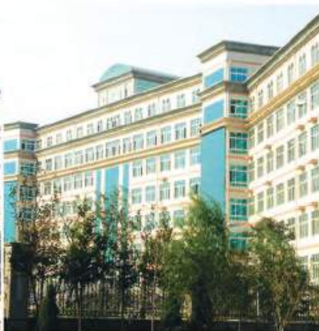
Kraj: Chiny Nazwa projektu: Szkoła techniczna Jinan Lanxiang Seria produktu: Chłodzony powietrzem modułowy agregat wody lodowej
