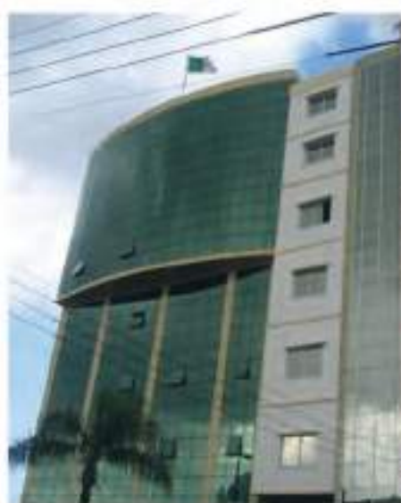
Kraj: Algieria Nazwa projektu: El Manara Center, Blida, Algieria Seria produktu: Chłodzony powietrzem modułowy agregat wody lodowej
