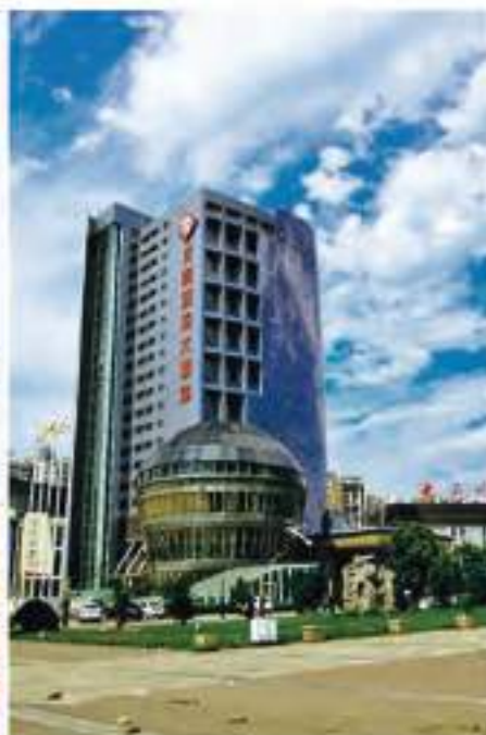
Kraj: Chiny Nazwa projektu: Hotel Henan Nanyang Longxin National Seria produktu: Chłodzony wodą odśrodkowy agregat wody lodowej z łożyskami magnetycznymi
