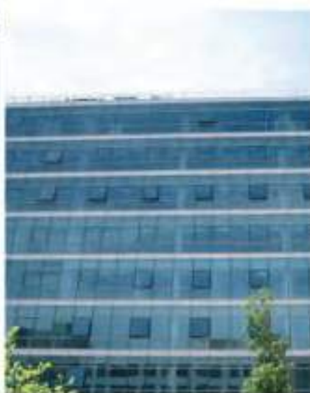
Kraj: Bułgaria Nazwa projektu: Budynek 6, Business Park Sofia Seria produktu: Chłodzony powietrzem modułowy agregat wody lodowej
