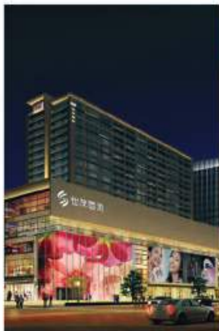
Kraj: Chiny Nazwa projektu: Budynek Beijing World Trade Seria produktu: Chłodzony wodą odśrodkowy agregat wody lodowej z łożyskami magnetycznymi
